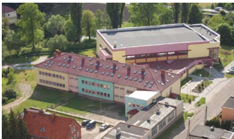
Hala sportowo-widowiskowa i Gimnazjum w Komornikach
